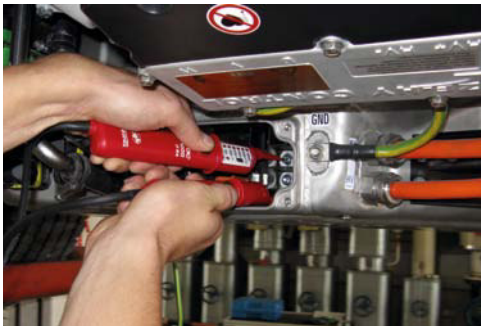
Bild 3: Spannungsfreiheit feststellen
