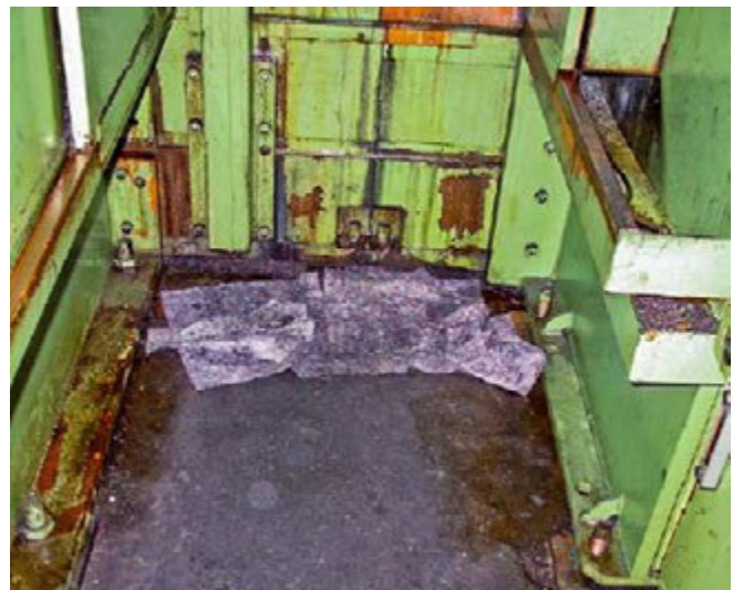
Abb. 4 Erhöhte Brandlast durch ölgetränkte Putztücher
