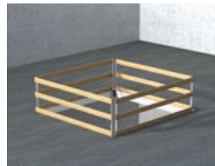
Abb. 5 Sicherung einer Öffnung durch Seitenschutz
