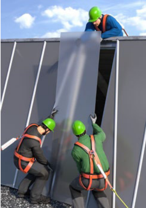
Abb. 7 Arbeiten unter Verwendung von persönlichen Schutzausrüstungen gegen Absturz als Rückhaltesystem
