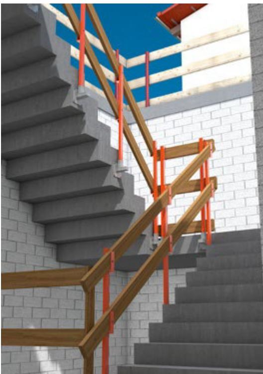
Abb. 4 Treppenaufgang mit Seitenschutz
