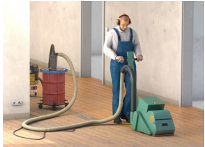
Abb. 11 Reduktion von Buchen- und Eichenholzstäuben mit Absaugung durch Bau-Entstauber
