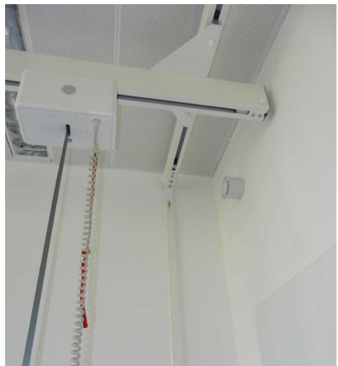
Bild 3 Portalmontage eines Patienten-Deckenlifters
