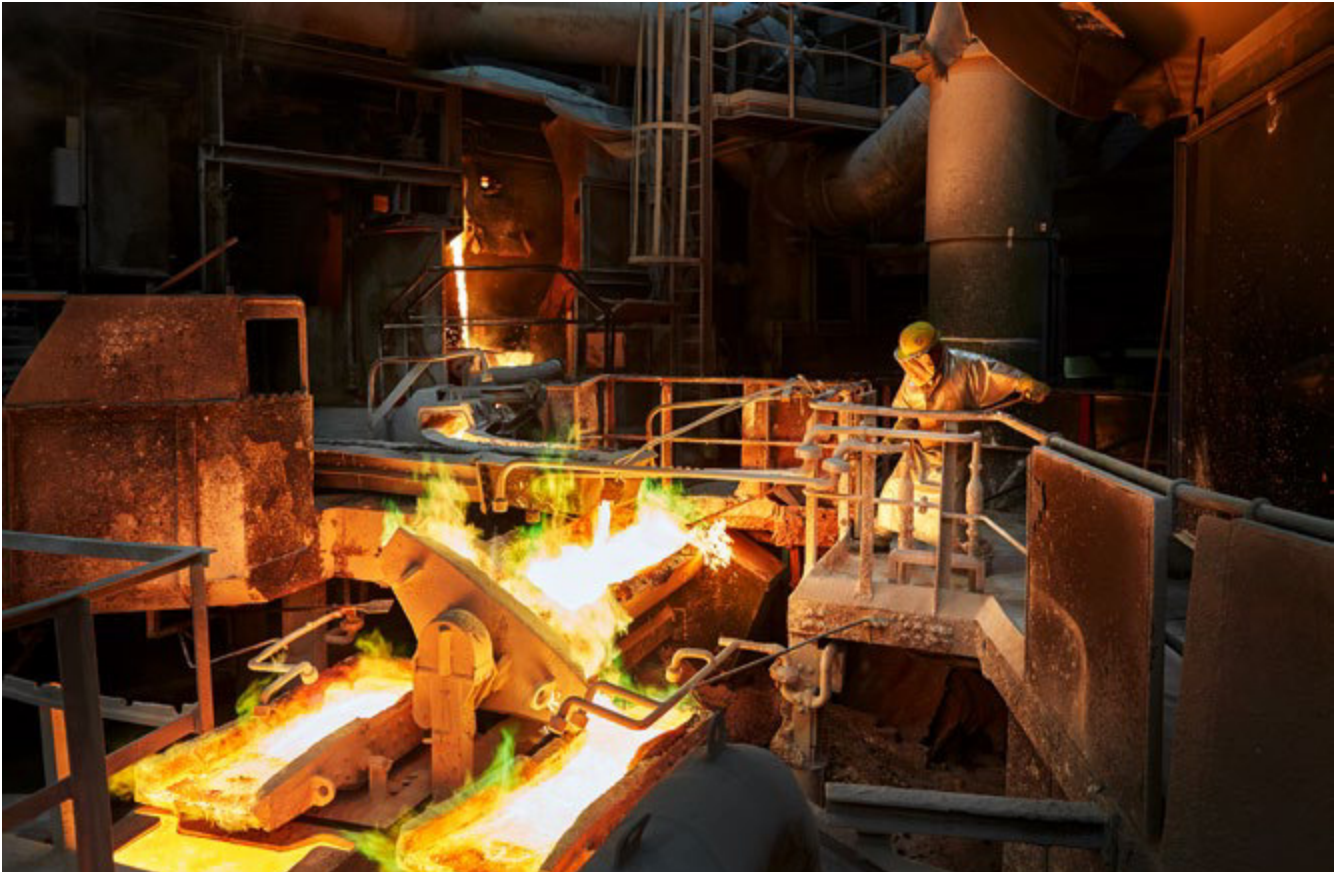
Abb. 1 Arbeiten im Abstichbereich
