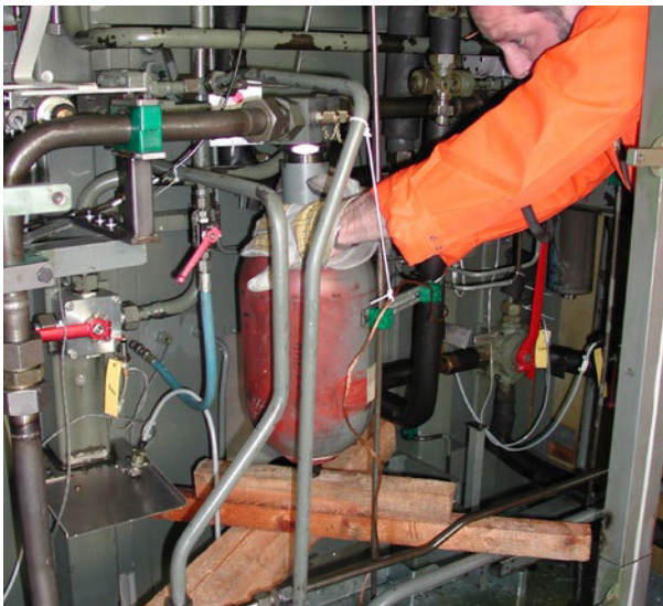
Abb. 1 Instandhalter bei Wartungsarbeiten
